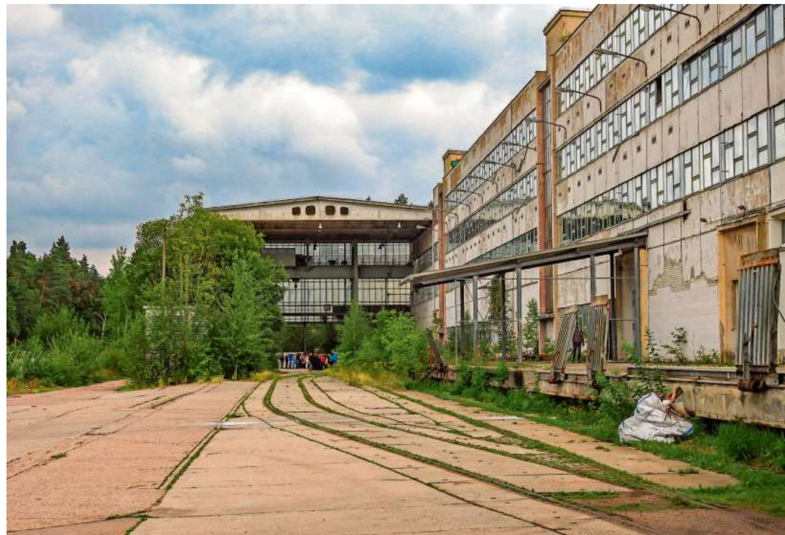
Sowohl Gebäude als auch Gebiet des ehemaligen Graf-von-Henneberg-Porzellanwerks sind mittlerweile ziemlich heruntergekommen.
